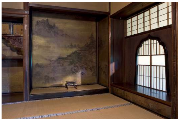
貴重な板ガラスが用いられた花頭窓
