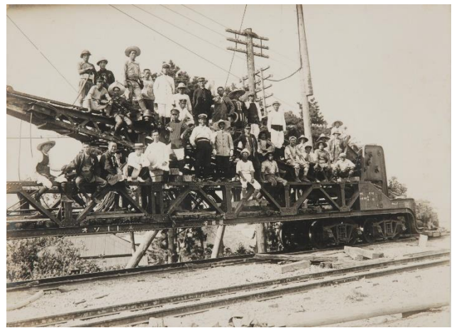
オソ10形貨車と復旧工事に従事した人びと 河邊啓太郎氏蔵・横浜開港資料館保管
