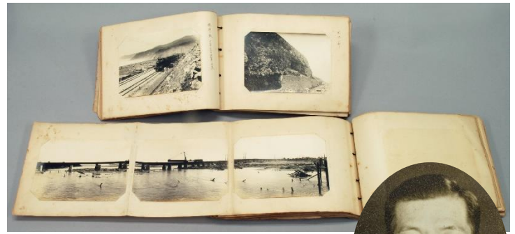
【上】関東大震災鉄道復旧工事写真帳
