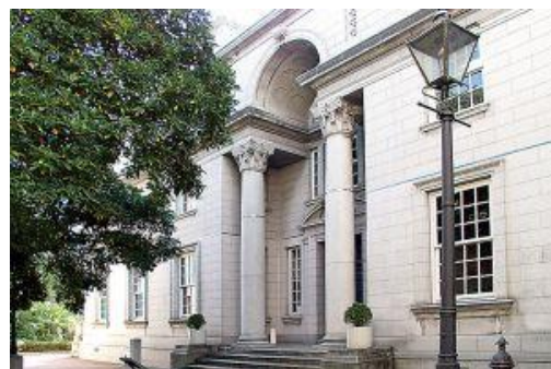
近代建築としても人気の高い旧館(旧英国総領事館)と中庭に植わる横浜開港のシンボルトまくすの木
