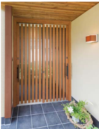
（施工イメージ）
