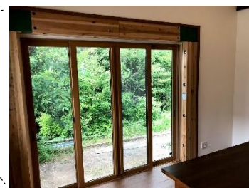
「FRAME II」(門型)設置箇所の様子
