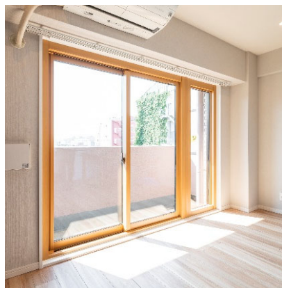
（左）施工前（右）施工後 引違い窓+FIX窓（連窓）
