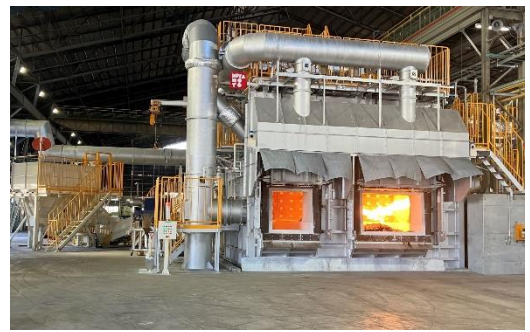
四国製造所 リサイクル炉
