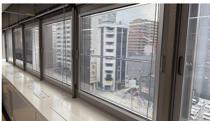
谷町 YF ビル 実装検証（写真左：BIPV 内窓設置後の外観全景 写真右：室内からの BIPV 内窓）
