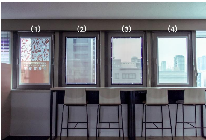
写真：ガラス型ペロブスカイト太陽電池による BIPV 内窓設置状態 ※社内運用専用画像部分を一部消去する画像処理を施しています
