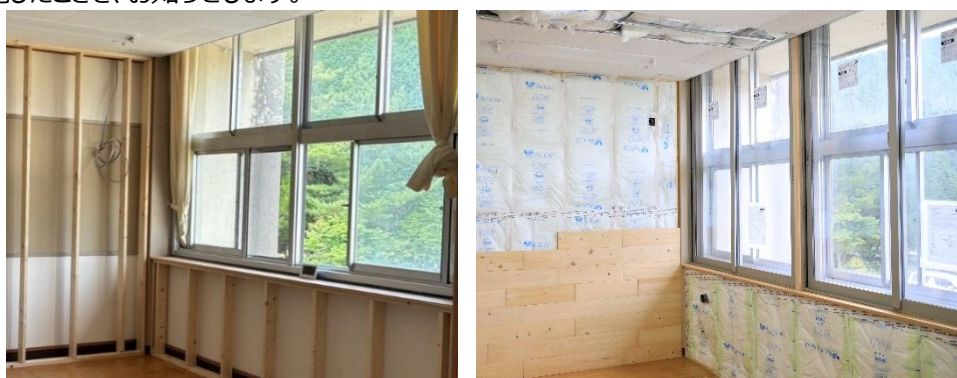
断熱改修（内窓設置、断熱材充填）の前【左】と後【右】
