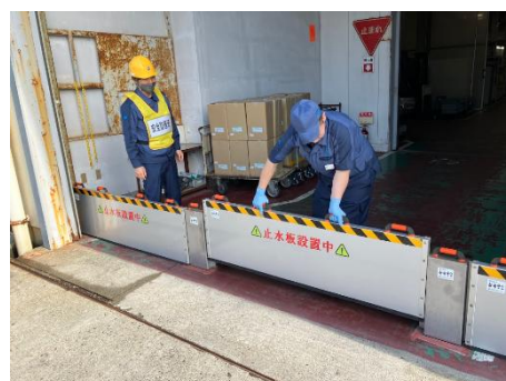
止水板の設置訓練の様子
