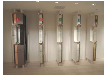
5つの部屋の断熱構造
