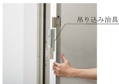
③吊り込み治具を使用した施工イメージ
