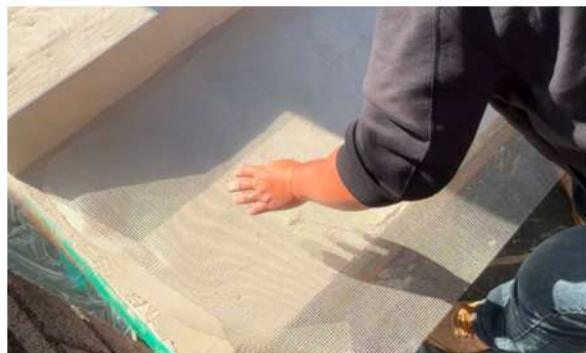
モルクラフト専用ベースを塗った上にグラスファイバー製のメッシュシートを敷き、モルクラフト専用ベースで伏せ込む作業を行います。
