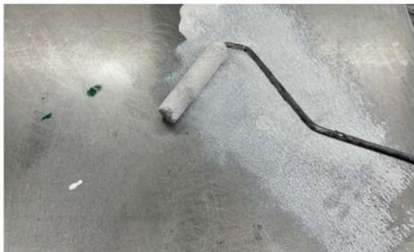
容器をよく振ってから専用強力プライマーを取り出し、原液のまま使用します。塗りにくい場合10%程度まで水でうすめることができます。
