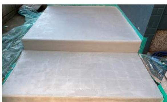
乾燥すると、メッシュシートが透けて見えてしまっているので、1回目よりもやや水分量多めに溶いたモルクラフト専用ベースを塗布してメッシュシートの目を完全に消す作業を行います。
