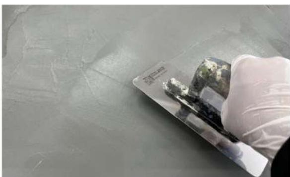
表面に触れてしっとりした感触だけれど手につかないくらいがコテで磨くベストな状態です。コテでなぞった部分が取れたり、施工面にゴミが出る場合は早すぎるのでもう少し乾燥させる必要がありますが、逆に乾燥させ過ぎると磨き作業ができないので注意が必要です。コテは常にきれいな状態で磨きます。
