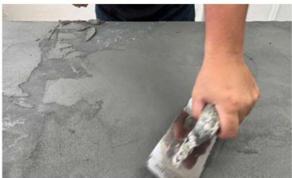
二度塗り目は、一度塗り目で出来た凹凸を埋めるようコテでうすく塗り広げて平らにします。二度塗り目も必要量は1m<sup>2</sup>で500gを使うくらいの目安でうすく塗り広げます。
