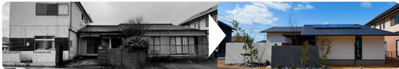
下関リノベーションモデルハウス(左:改修前/右:改修後)
