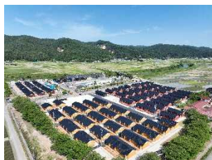
能登半島地震木造応急仮設住宅 623 戸に採用
