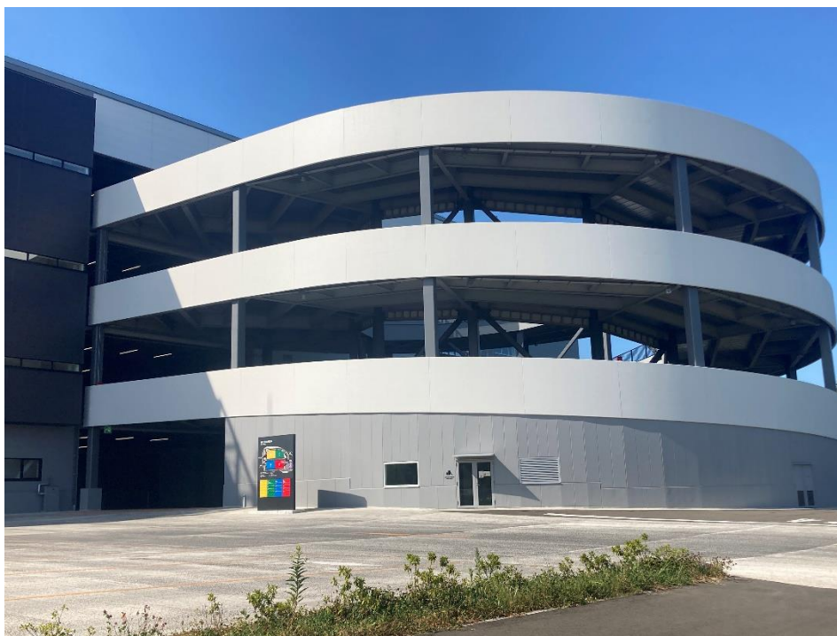
四街道ロジスティクスセンター
