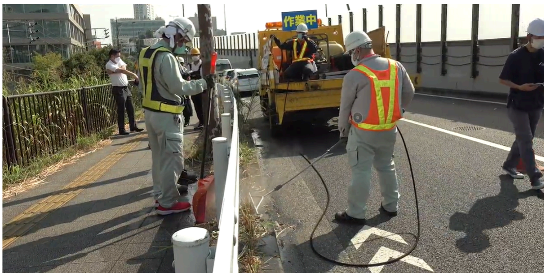
国道における温水除草の様子(日本ロード・メンテナンス株式会社様)
