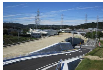
国道163号バイパス整備
