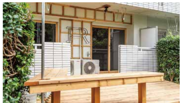
AFTER：1階の部屋をリノベーション。解体工事で出た廃材を再利用して空間を造りました。
