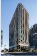
東京日本橋タワー
