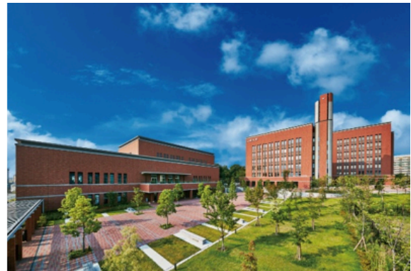
大和大学(大阪府吹田市)
