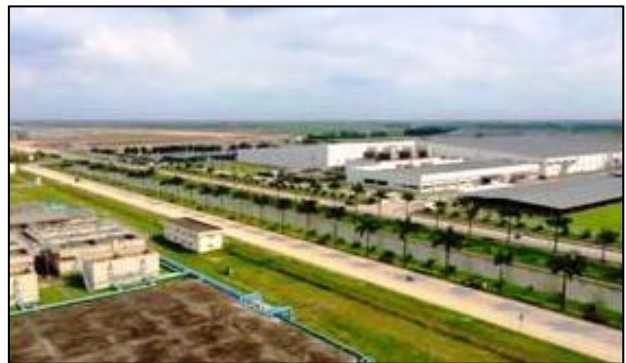
第2タンロン工業団地外観
