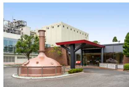
<キリンビール取手工場外観>
