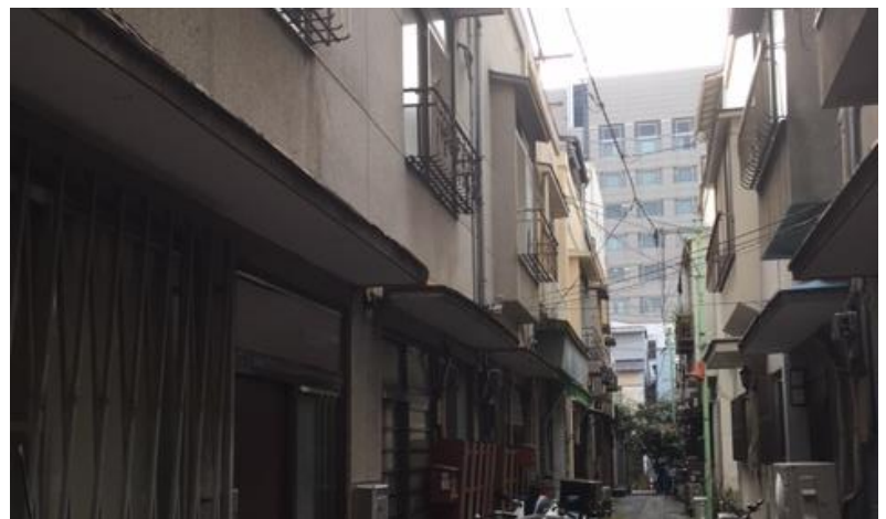
工事車両進入困難で建替えが進まなかった私道
