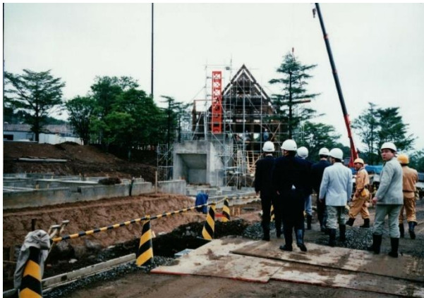
▲ ブリティッシュヒルズ建設中の写真
