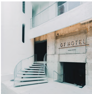
ホテル外観エントランスまわり
