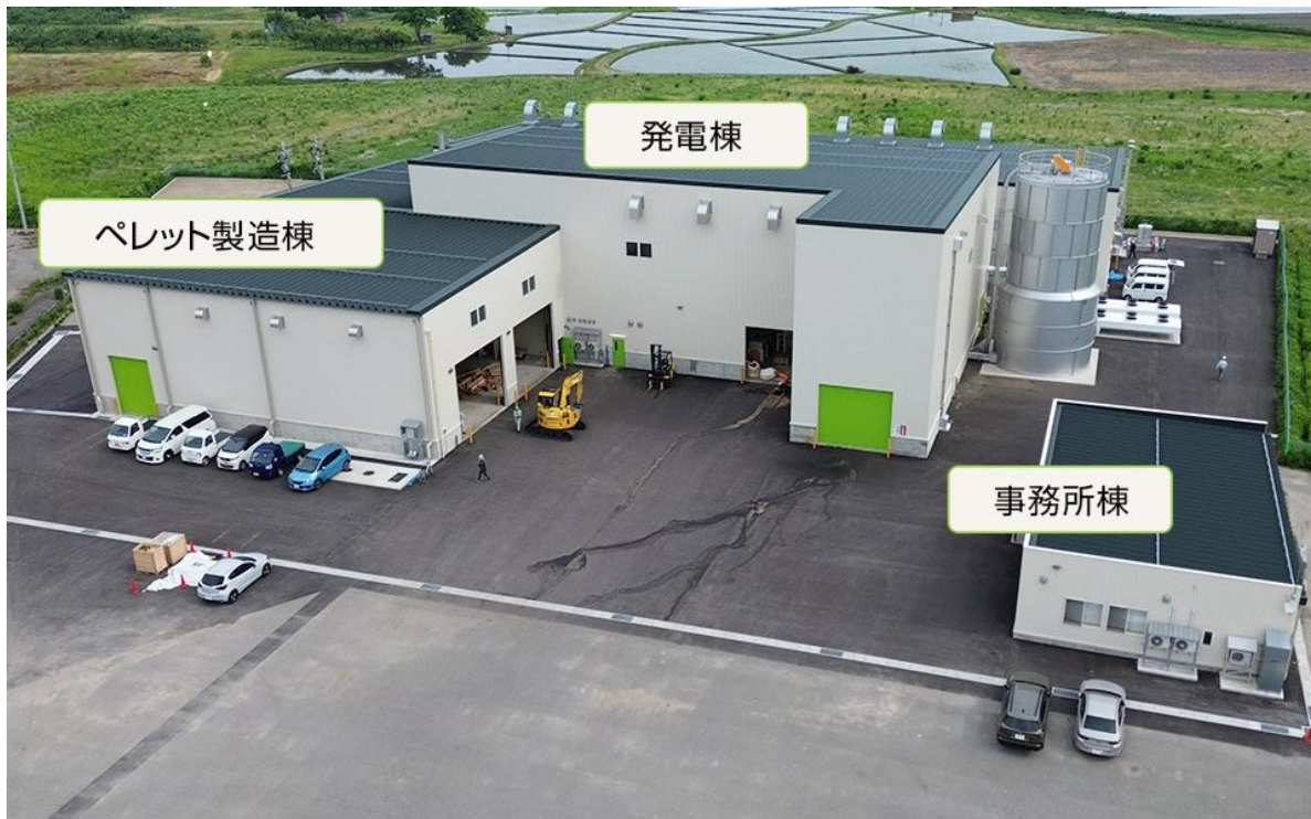
横手発電所全景
