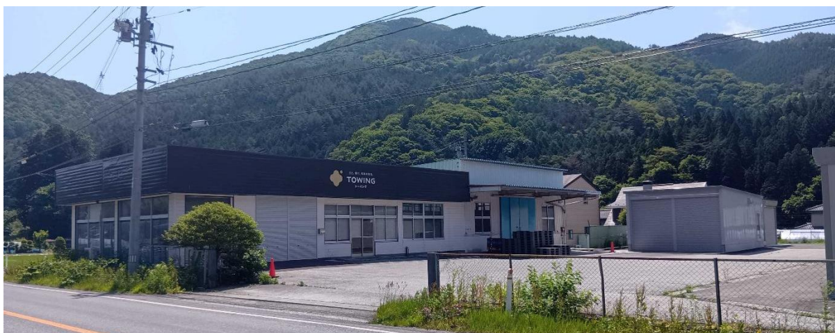
2025年4月に試験稼働を開始したTOWING岩手プラント
