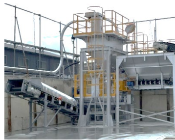
建設発生土改良処理（固定式）
