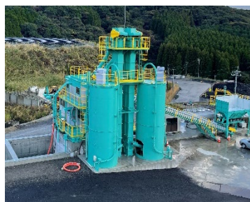
建設汚泥リサイクル
