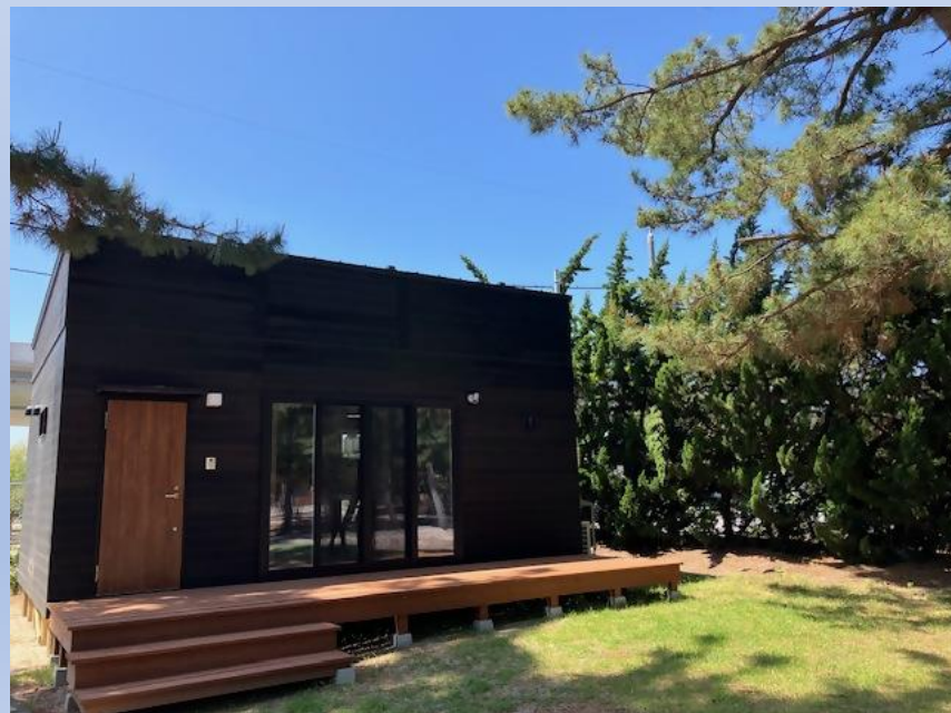
内装・外壁・ウッドデッキは県産材使用
