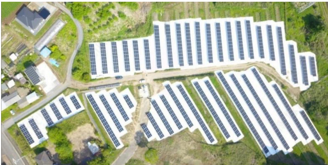
リパワリングを実施した小美玉市発電所の全景
