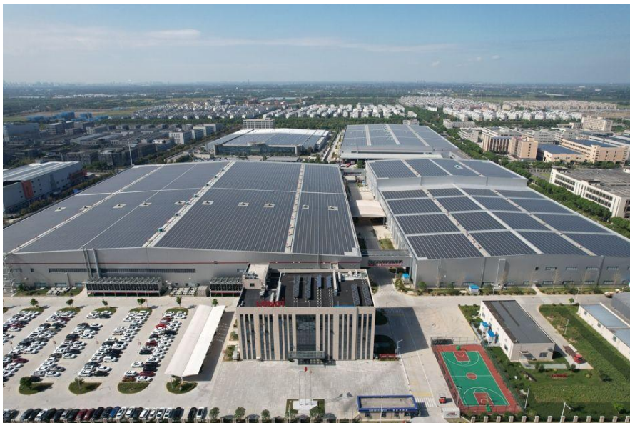
LONGi・嘉興工場の屋上に設置された太陽光発電システム
