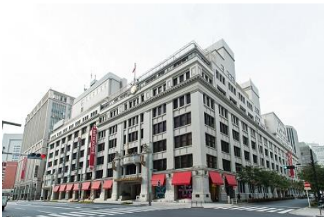
日本橋三越本店 外観
