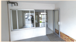
玄関・駐車場
