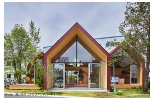
【審査員評価コメント】CLT材の特徴を利用して、板材を組み合わせただけに見える特徴的で簡素な仕上げを実現している。さらに、そのような表面的なデザインだけでなく、増改築の簡便さまで視野に入れた CLT 材ならではの構法の可能性に取り組んでいる姿勢も評価した。このような統合的なデザインへの取り組みがさまざまに蓄積されることが、小規模木造建築への CLT 材の普及に寄与すると考える。
