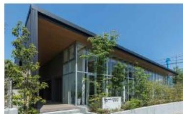
ラミナ張弦梁を化粧あらわしにすることで、船底のような屋根構造が浮遊する内観を創り出し、木質空間を演出しています。外壁面のほとんどをガラスサッシで構成することで、外部からもラミナ張弦梁を視認できるようになっています。特に夜間には、室内のライティングによって、ラミナ張弦梁とともにセンターハウスの内観がヒルサイドテラス若葉台のシンボルとして浮かび上がります。
