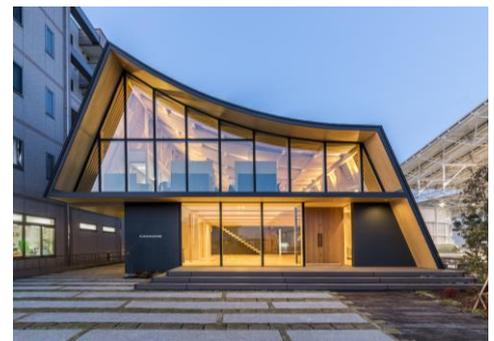
【審査員評価コメント】木造メーカーの支店。建築地場産流通材の比較的小径の部材を組み合わせた綺麗なカテナリー曲線の屋根が特徴的である。筑波山の稜線に重なり、この建物のアイコン的な要素となっている。大きな空間を無柱空間とすることができ、とても開放的なオフィス空間が実現できている。一般的な部材の組み合わせによって驚くほどの低コストで実現できており、事務所建築の木造化のよい一例となっている点が、評価が高かった。
