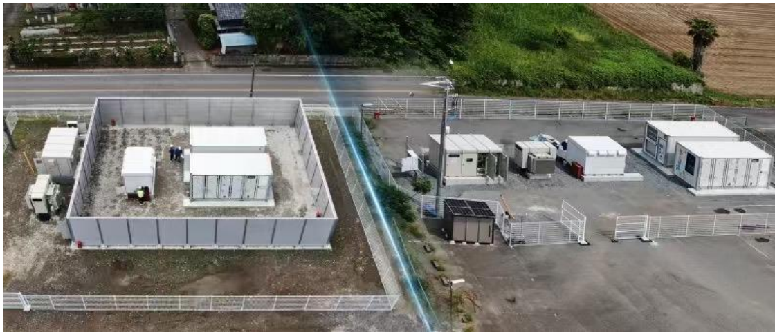
蓄電所現場およびエンジニアの作業風景
