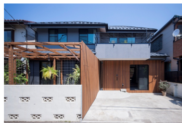
戸建てリノベーション
