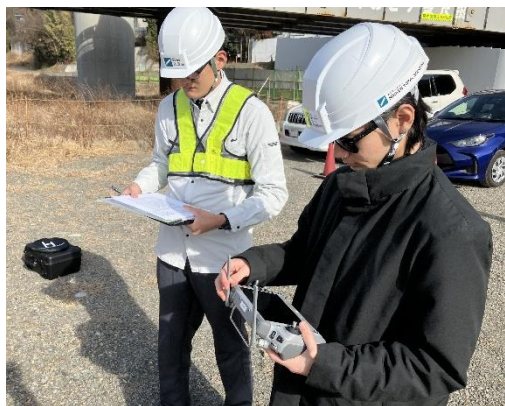
ドローンを操作し測量を行う様子
