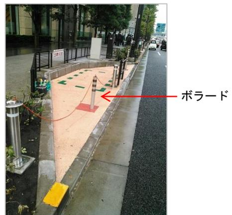
※当ステーションにはライジングポラードを設置しています。ご利用の際は、車両に搭載しているリモコンでポラードを操作する必要があります。
