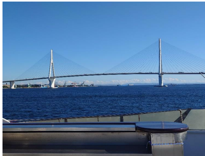
屋上デッキから: 鶴見つばさ橋
