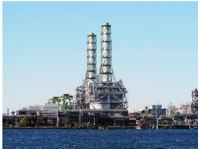
川崎天然ガス発電所
