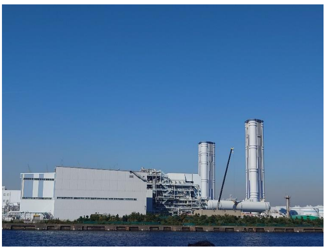
JERA川崎火力発電所
