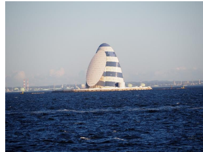
東京湾アクアライン 川崎側換気塔 「風の塔」
