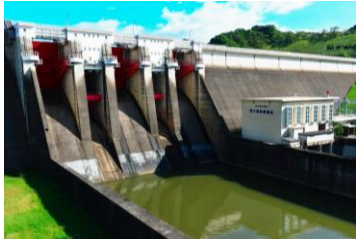
岩手県営水力発電所
