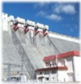
秋田県営水力発電所
