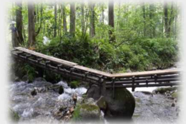
委員会によるトクサ沢（小沢平峠）の架橋
