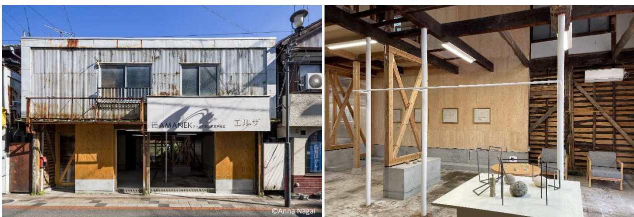
左：一期工事改修後、前面ファサード。補強計画をそのまま意匠として見せることで次の動きを予感させるデザイン、右：地域のギャラリーとして公開
