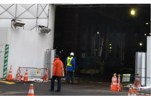
工事車両の出入り口
