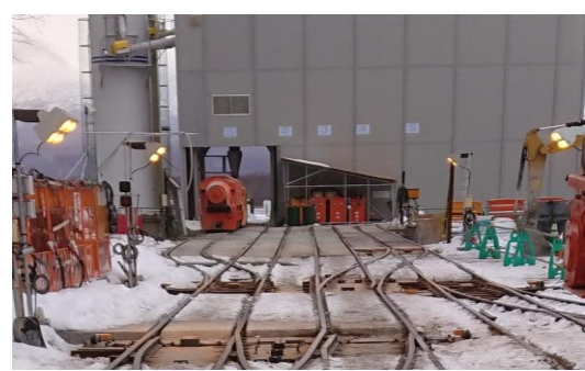
トンネル工事現場
