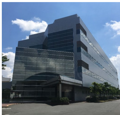
ポーラ化成工業 本社・横浜研究所
