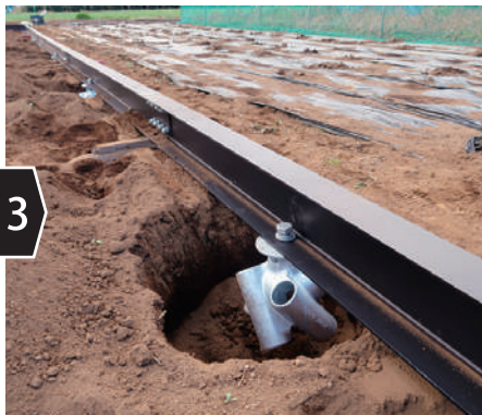
3 基礎にフレームを取付ける
