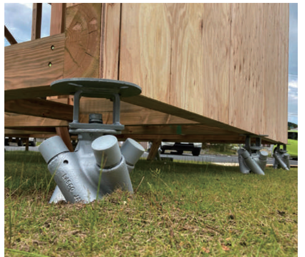
フレーム無しで基礎（BGF 金具）の上に直接、建物を接続できます
