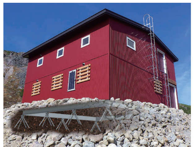
建物の下、土の中にはスパイクフレームがあります
