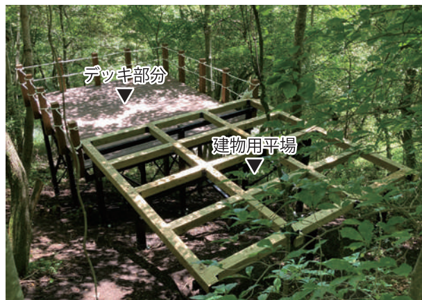
フレームと支柱を組み合わせることで急斜面地でも設置可能
