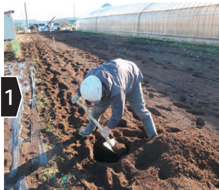
基礎設置位置に穴を掘る
