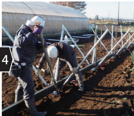
4 鋼管を差し込み電動工具で打ち込む
