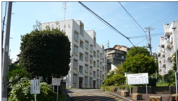
従前の大和町共同住宅
