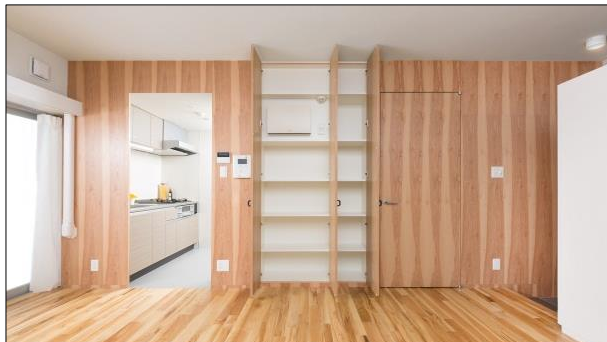
床や壁に里山産材を活用した内装材
