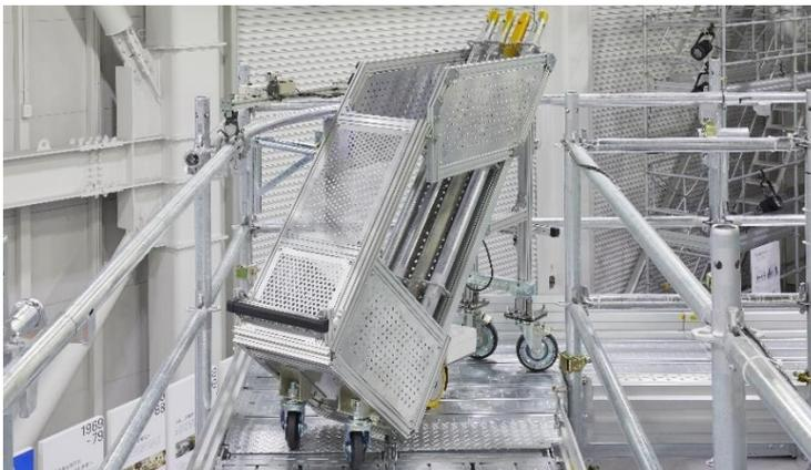
Innovation Hub 中央に位置するタカミヤのソリューションを提案する展示エリア。こちらでは足場内運搬システム「T-Rook」を紹介。約 70%は運搬作業が占めると言われる足場内作業。人手不足が叫ばれる建設業界へのソリューションとして、タカミヤは「ロボティクス」に着目し、開発に着手しました。このロボティクスは、最大 150kg の積載を可能とし、スピードは昇降で時速 20kg、横移動で時速 4 キロ（人が歩くスピード）です。今後も「省人省力化」「生産性向上」をキーワードに研究開発を進めてまいります。
